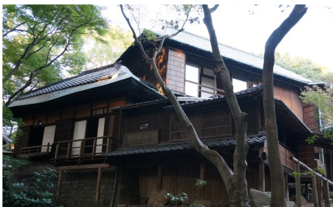
▲修理工事前（平成27年）
