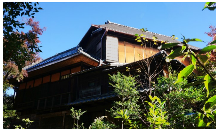
▲修理工事完了後（令和2年秋）
